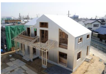
キューワンボード施工後
