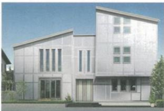
▲アルミ樹脂付断熱断熱材を施工した状態。この後、サイディングで仕上げる
