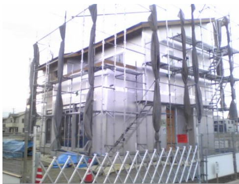
<外張断熱施工後>
